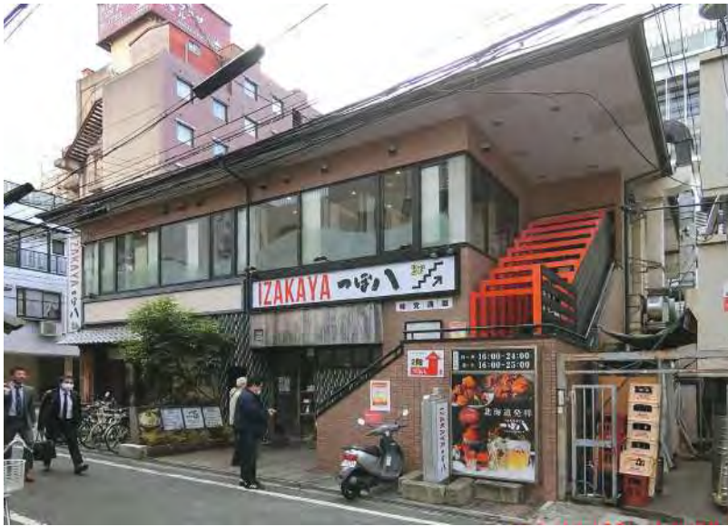
ファサード全景
